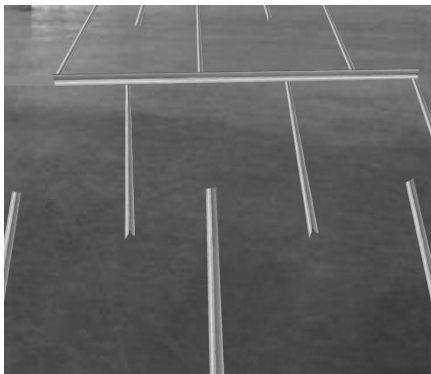
(b) 压电式称重传感器的安装位置
